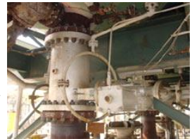
ゲート弁から取り換えられたTRITEC 300LB-16B
